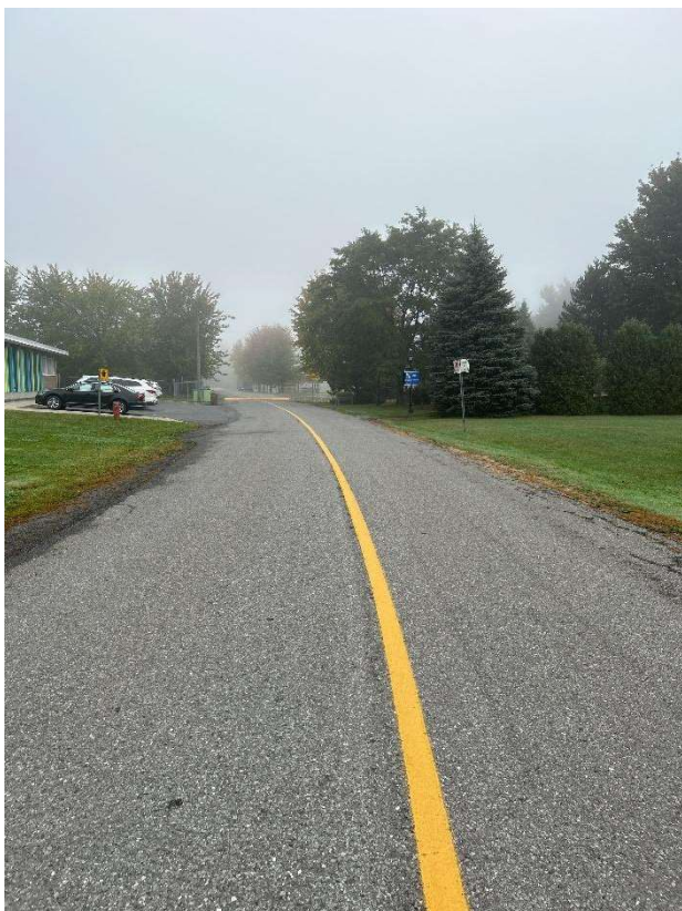
Figure 11 : Rue de l'École sans aménagement
