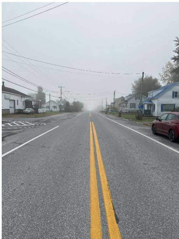
Figure 12 : Rue Principale sans séparation physique
