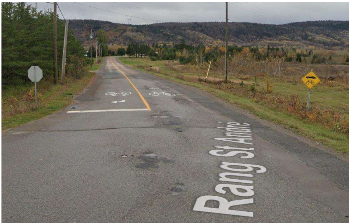
Figure 25 : Exemple d'une chaussée désignée, rang Saint-André, Hébertville (Google Maps)
