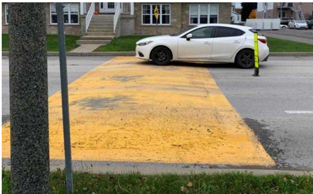
Figure 29 : Dos d'âne allongé, Rue Majeau, L'Épiphanie
