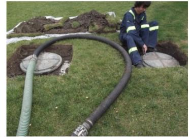
**Lorsque les installations possèdent un système muni d'une pompe de type Bionest, la Régie demande au citoyen de l'en aviser. La pompe doit être mise hors tension lors de la vidange. Un écriteau doit être laissé près du couvercle afin d'informer l'entrepreneur que la pompe est fermée**
